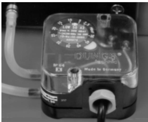
Реле контроля давления воздуха работает как дифференциальное реле давления и служит для контроля давления у горелок с наддувом.
