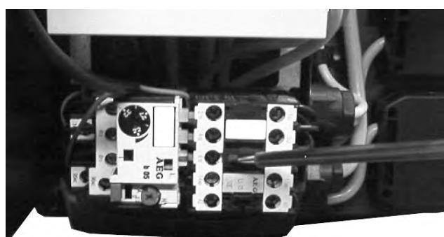
После завершения работ по подключению необходимо проверить правильность подключения электропроводки и задействовав кратковременно защиту электродвигателя горелки с помощью изолированной отвёртки, проверить направление его вращения. Направление вращения считается правильным, если колесо вентилятора вращается в направлении стрелки (см. на направление стрелки на фланце электродвигателя)
