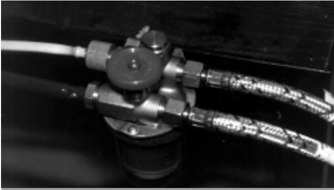
При переводе на однолинейную систему рекомендуется установка жидкотопливного фильтра с подводом обратной линии. При этом насос продолжает функционировать в двухлнейной системе. Присоединить входной и обратный шланги горелки к фильтру. Открыть топливный кран на фильтре. Произвести пуск установки.
